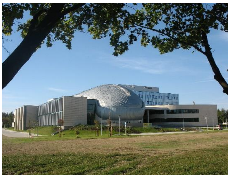
Flagowy budynek V Politechniki Rzeszowskiej
